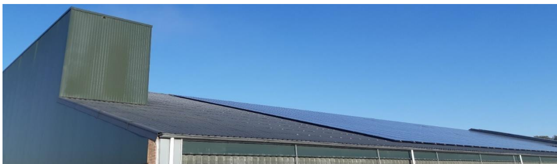
Goede afstand tussen luchtwasser en PV
