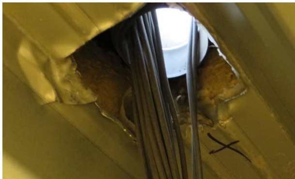
Verkeerde dakdoorvoer
