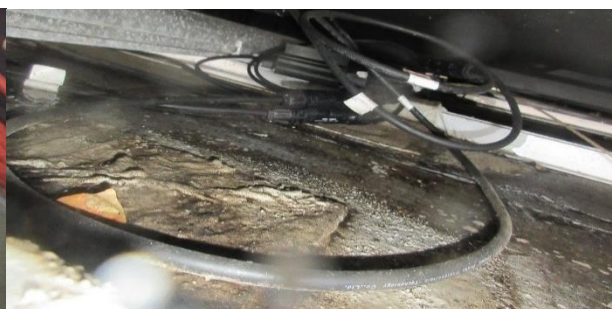
Connectoren liggen op het dak en de panelen te dicht op het dak
