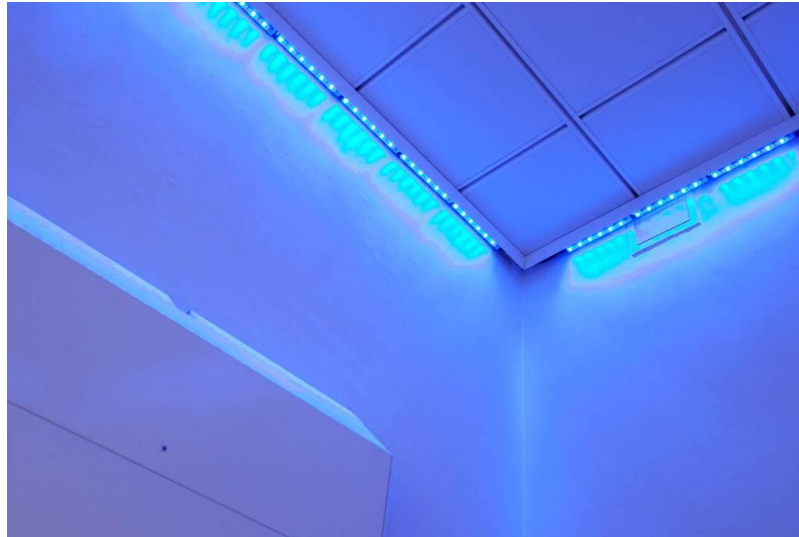
Figuur 11 RGB-verlichting toegepast in een separeerkamer (FPA Palier (Parnassia), Den Haag).
